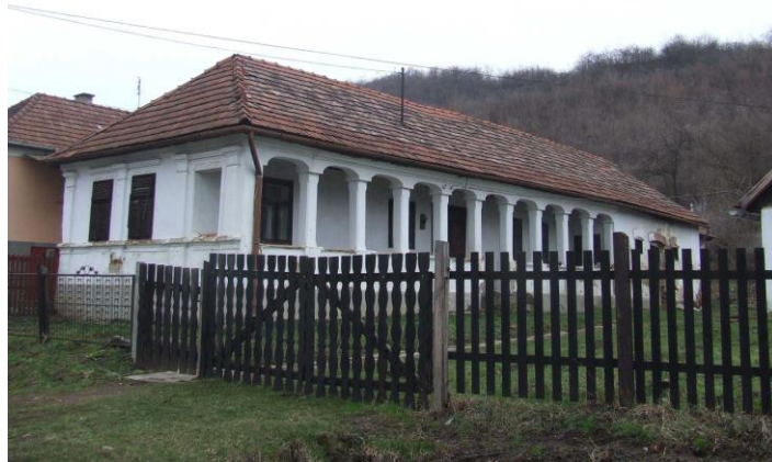
15. kép: a leendő Tájház épülete
